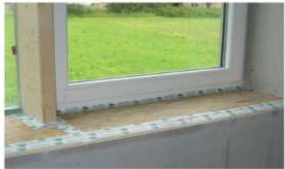
Fig. 19 Window airtightening
