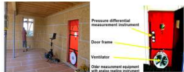
Fig. 7 Blower Door test
